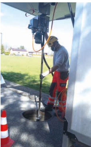
Hochdruckreinigung mit TSSR
