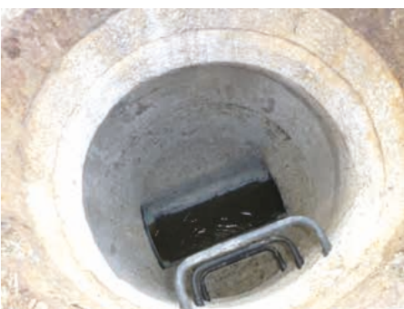
Schachtbauwerk vor der Reinigung (l.), nach der Wasserhochdruckreinigung mit TSSR (Mitte) und nach der Beschichtung mit KS-ASS-Technologie (r.) | Fotos: Strabag AG
