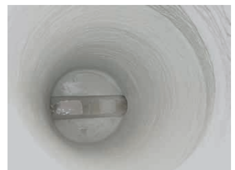
Schachtbauwerk vor der Reinigung (l.), nach der Wasserhochdruckreinigung mit TSSR (Mitte) und nach der Beschichtung mit KS-ASS-Technologie (r.) | Fotos: Strabag AG
