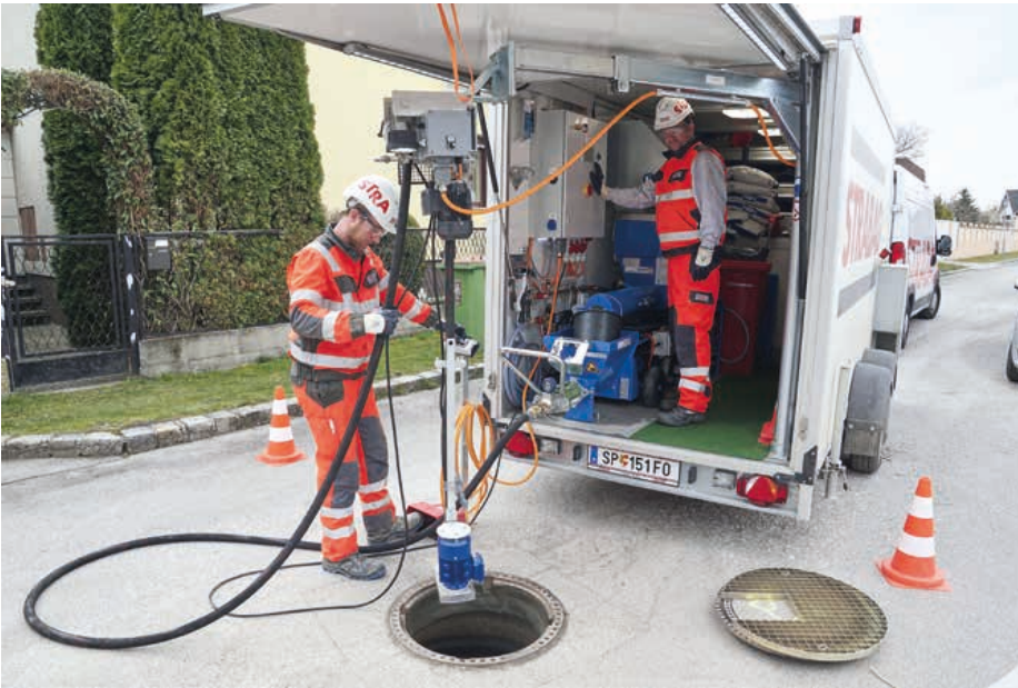
Schachtbeschichtung mit Automatikwinde
