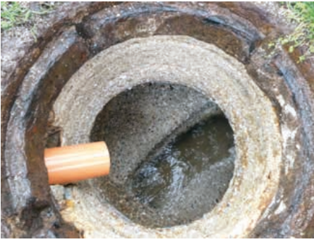
Schacht nach der Hochdruckreinigung mit TSSR
